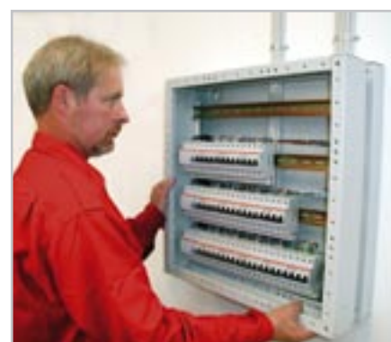
Kabler samt forramme monteres.
